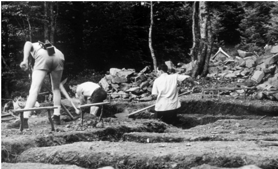
Le fondamenta del Rifugio
