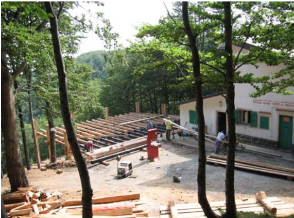
I lavori per la costruzione della terrazza in legno
